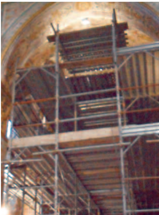
La cappella di S. Martino durante i lavori
