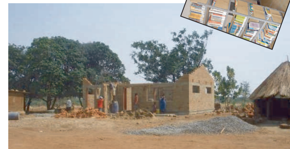
Nuovo blocco della scuola, in costruzione
