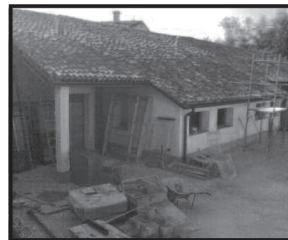
I lavori di allargamento della Mensa
