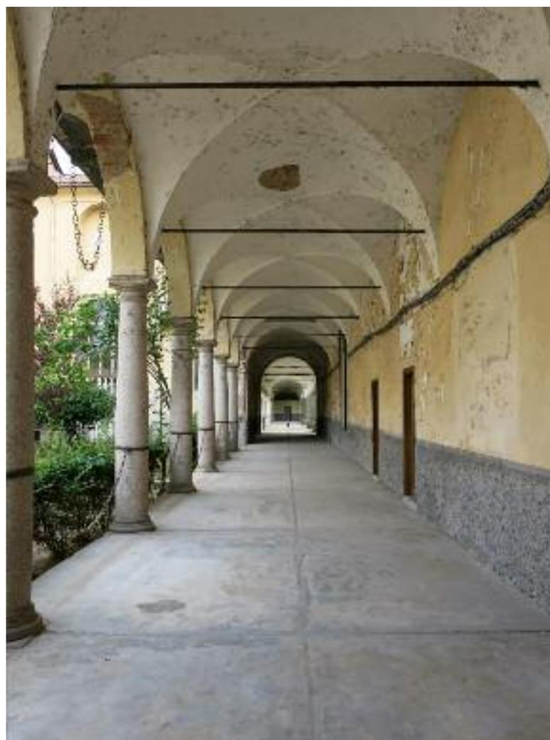
Il portico ha volte a crociera e colonne in granito, i corrispondenti ambienti al piano terra e al primo piano sono coperti da volte a padiglione o a crociera mentre il corpo trasversale ha due stanze al piano terra e al primo piano grandi ambienti con solai lignei. Le colonne del portico presentano lacune ed erosioni delle parti lavorate a rilievo dei capitelli e dei basamenti.
