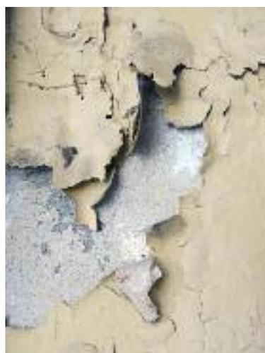
I fenomeni di degrado sono imputabili essenzialmente alla mancanza di manutenzione, i danni più rilevanti sono localizzati al piano terra, sotto il portico e nell'androne dove anche la decorazione ad affresco visibile versa in condizioni molto mediocri.
